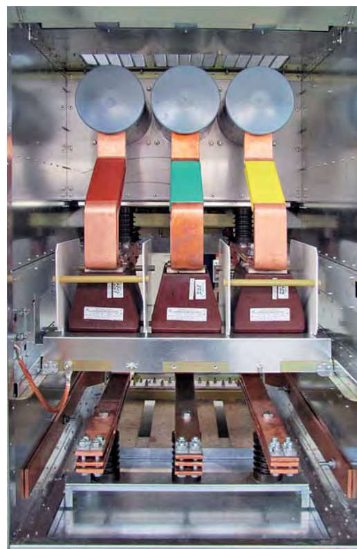
Кабельный отсек
